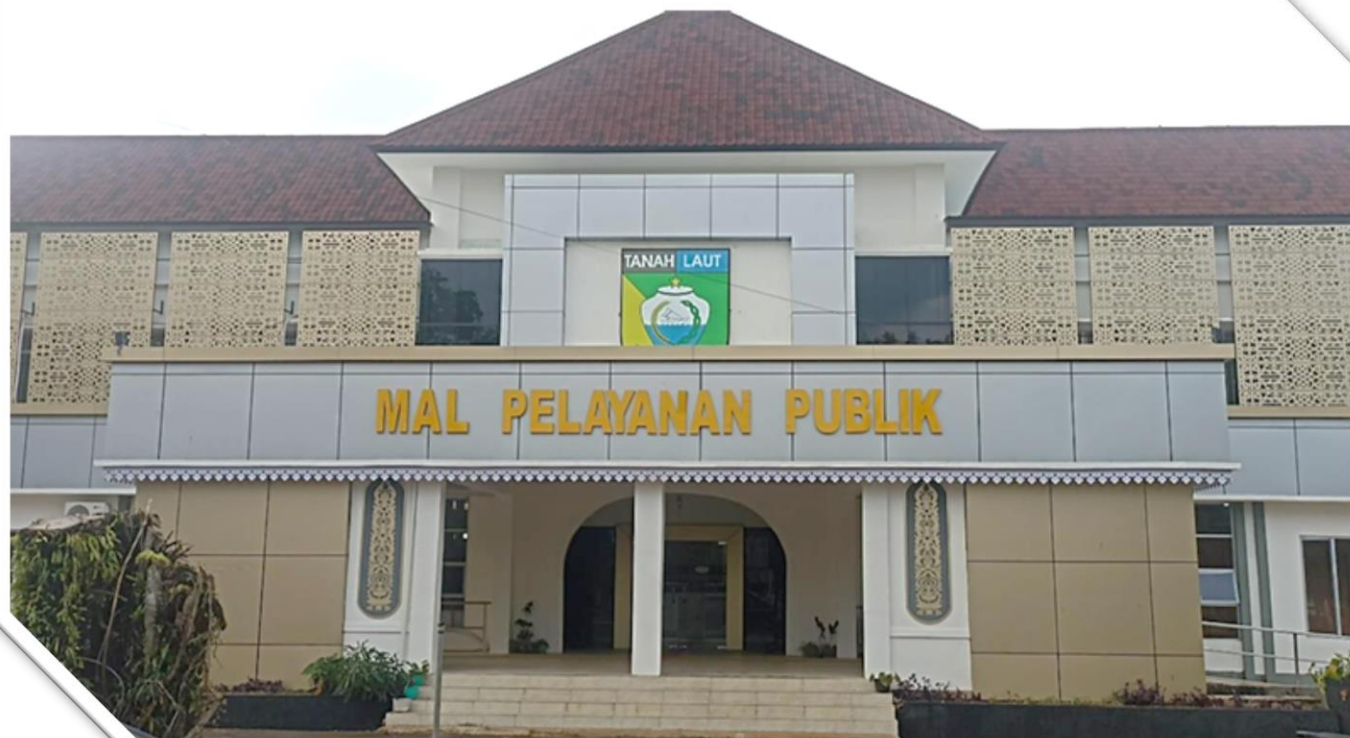
FOTO TAMPAK DEPAN GEDUNG MPP TANAH LAUT :
